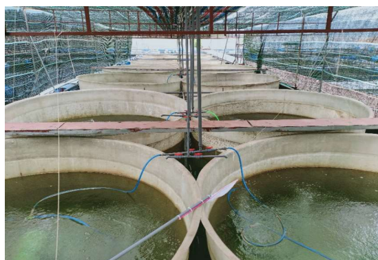
Hình 2: Hệ thống bể ương cá Chình giống; hệ thống cấp nước, mái che, sục khí
